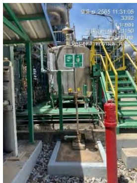
ภาพที่ 2-30 อ่างล้างตาและฝักบัวฉุกเฉินบริเวณโครงการ
