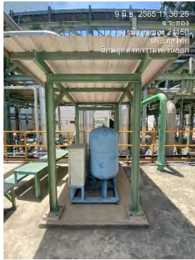
ภาพที่ 2-9 การติดตั้งอุปกรณ์รดน้ำต้นไม้และน้ำทิ้ง กลับมาใช้ประโยชน์ในการรดน้ำต้นไม้ในพื้นที่โครงการ
