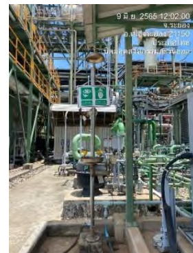
ภาพที่ 2-30 อ่างล้างตาและฝักบัวฉุกเฉินบริเวณโครงการ
