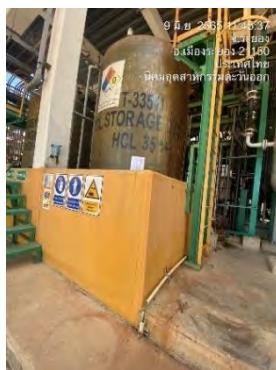
ภาพที่ 2-32 คันกันล้อยมรอบถังเก็บสารเคมีป้องกันการรั่วไหล
