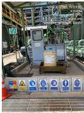
ภาพที่ 2-30 อ่างล้างตาและฝักบัวฉุกเฉินบริเวณโครงการ
