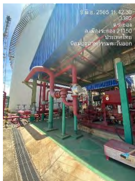
ภาพที่ 2-34 เครื่องสูบน้ำดับเพลิง
