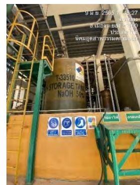
ภาพที่ 2-32 คันกันล้อยมรอบถังเก็บสารเคมีป้องกันการรั่วไหล
