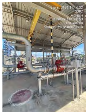
ภาพที่ 2-38 อุปกรณ์ความปลอดภัยของระบบท่อส่งก๊าซ
