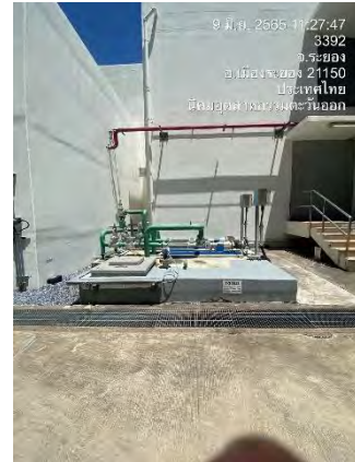
ภาพที่ 2-14 ถังแยกน้ำ-น้ำมัน (Oil Separator Tank)
