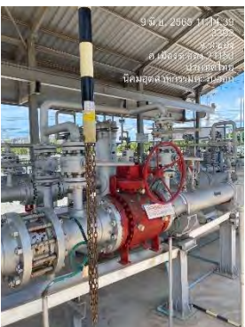
ภาพที่ 2-38 อุปกรณ์ความปลอดภัยของระบบท่อส่งก๊าซ
