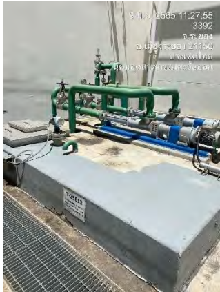
ภาพที่ 2-14 ถังแยกน้ำ-น้ำมัน (Oil Separator Tank)
