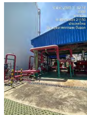
ภาพที่ 2-35 ท่อน้ำดับเพลิงและหัวจ่ายน้ำดับเพลิง
