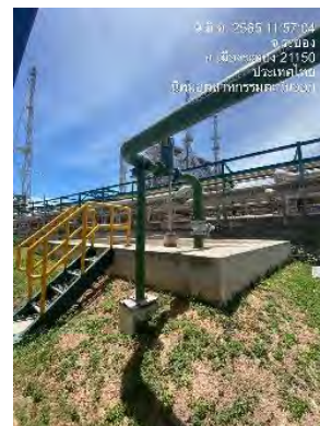
ภาพที่ 2-2 บ่อพักน้ำทิ้งฉุกเฉิน (Emergency Pond)
