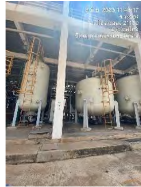
ภาพที่ 2-10 ถังปรับสภาพ (Neutralization Basin)
